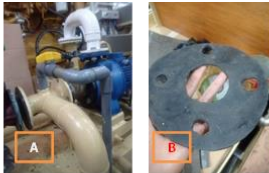
Gambar 16. (A) Sambungan pipa dan pompa bilge dan (B) Gasket pipa dan pompa bilge
