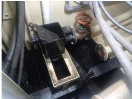
Gambar 12. (A). Box Filter dan (B) Mulut Pipa Penyedot Air
